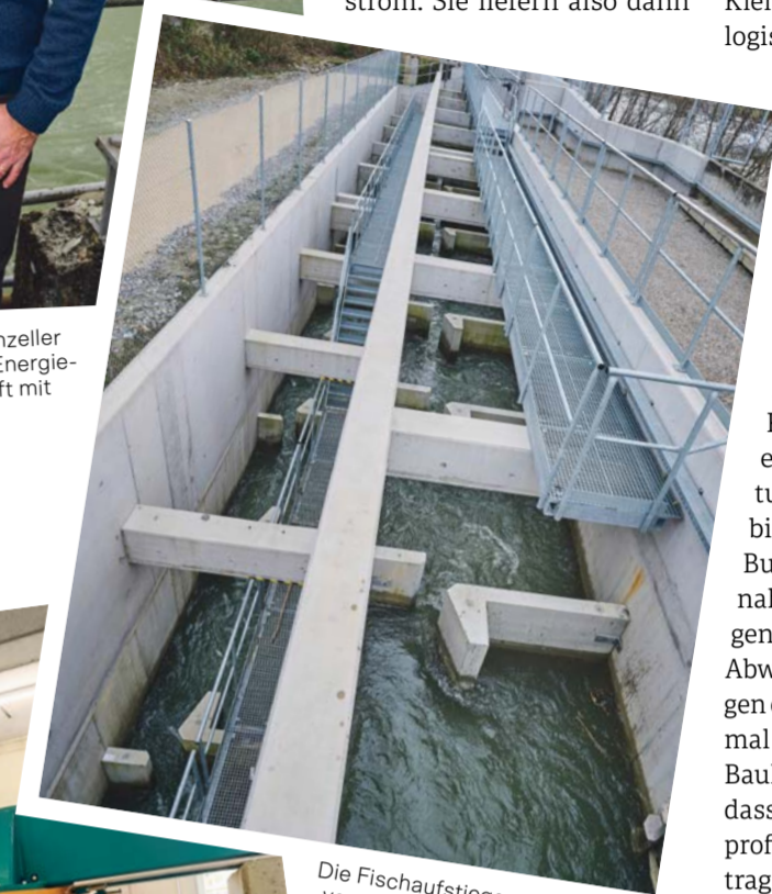
Die Fischaufstiegsanlage wird verwinkel durch den Betonbau des Einlaufbauwerks geführt.
